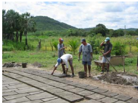
A produção de placas para construção de cisterna
